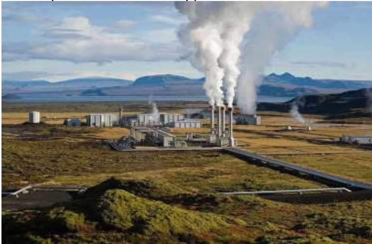
La stazione geotermica di Nesjavellir fornisce energia alla zona di Reykjavík
