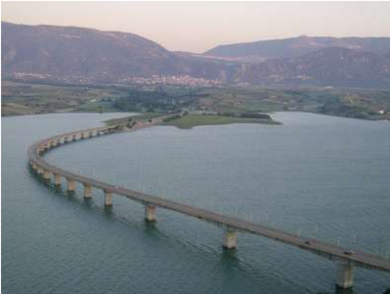
Il ponte (1352 m) sul lago artificiale del fiume Aliacmone
