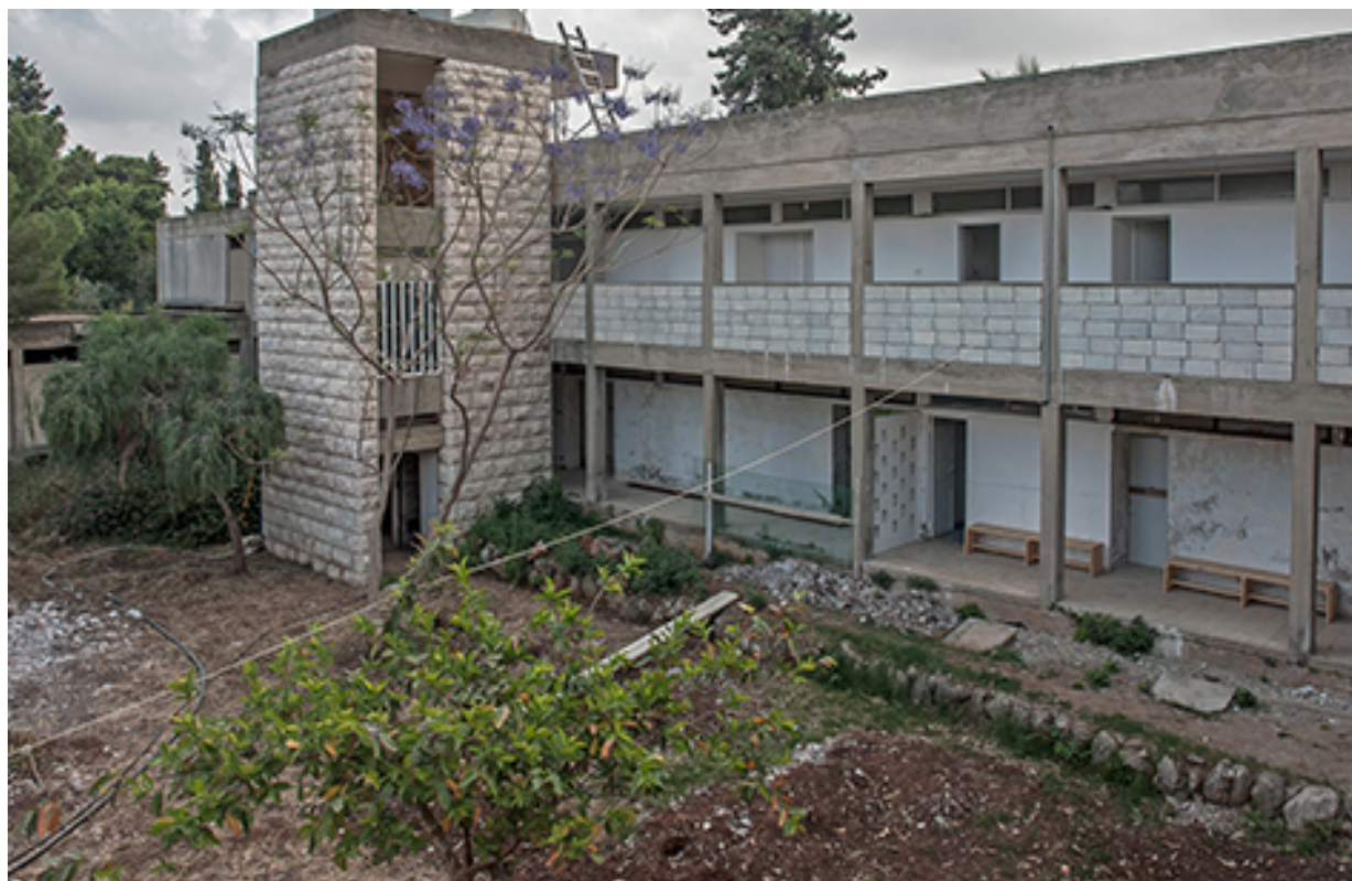
Un'ala dell'edificio che ospita il Progetto Fratelli a Rmeileh: al piano terra ci sono le aule e i servizi igienici, al primo piano gli alloggi e la cucina a disposizione dei religiosi.
